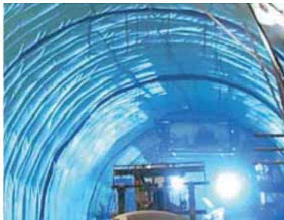
Uno dei principali sbocchi applicativi del PVC-R VinyLoop è rappresentato dalle membrane per l'impermeabilizzazione di tunnel e gallerie
