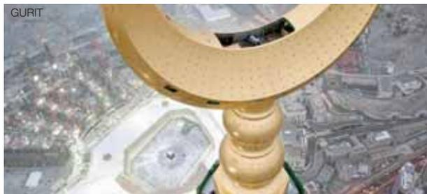
Tra i materiali utilizzati figura un nuovo sistema ignifugo (Ampreg 21 FR), sviluppato per la laminazione della facciata.
