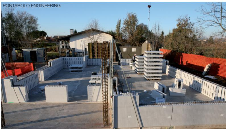
Costruire con sistemi ad armatura diffusa in EPS consente di ottenere edifici sicuri ed efficienti in termini di isolamento termico e acustico, resistenza al sisma e comporta-
