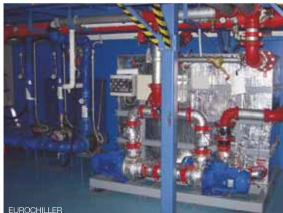
lizzata nella produzione di film in polietilene e lastre acriliche. La macchina fornita in versione FT auto-drenante lavora in completa assenza di glicole ed è completa di vasca di recupero acqua in caso di scarico durante i fermi impianto, oltre che di gruppo di accumulo e pompaggio installato a bordo linea.
