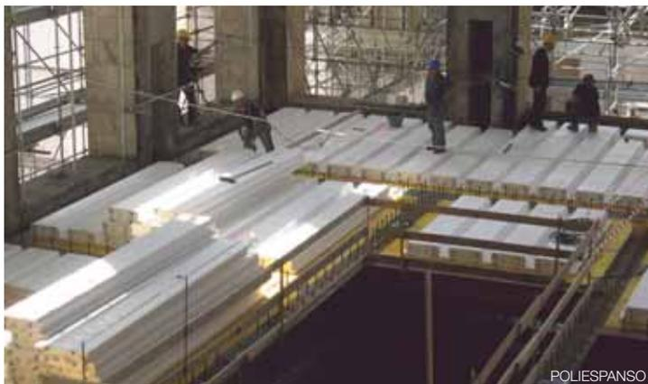
al fuoco degli elementi in opera, oltre all'eccellente coibentazione garantita alla struttura. La continuità dell'isolamento è assicurata dalla battentatura dei pannelli per evitare la formazione di ponti termici.
