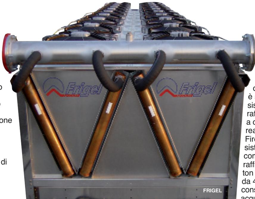
alcune norme limitative del consumo di questo elemento introdotte nel Nord Carolina per fare fronte e prevenire fenomeni di siccità. A tale scopo è stato adottato un sistema di raffreddamento Ecodry a circuito chiuso realizzato da Frigel Firenze. Mentre il sistema precedente, composto da torre di raffreddamento da 500 ton (1.760 kW) e chiller da 400 ton (1.400 kW), consumava molta più acqua di quella consentita dalle
