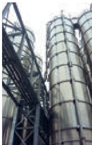
Linee di alimentazione multiple provvedono al caricamento di 12 silos di stoccaggio
