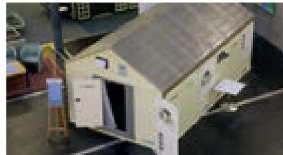
Alloggio provvisorio RHU realizzato con tubolare d'acciaio ricoperto con pannelli o teli in plastica e dotato di schermo protettivo che riflette la luce e assorbe calore (foto: Ikea)
