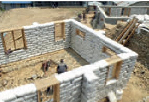
Il sistema Earthbag prevede la sovrapposizione di sacchi tessuti in polipropilene riempiti con sabbia o terra umida
