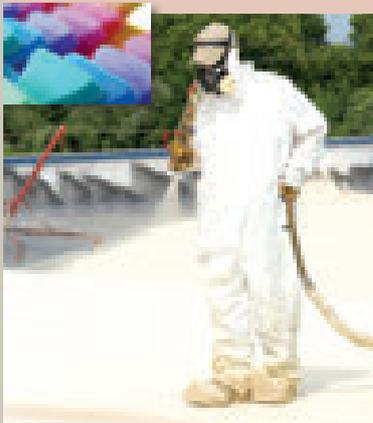
Esempi di espanso flessibile ed espanso a spruzzo (foto: Aggressive Roofing Systems e Ramfoam)
