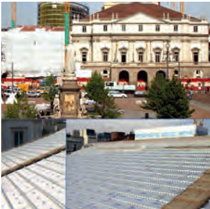
Isolamento del Teatro alla Scala di Milano con pannelli in poliuretano (foto: Brianza Plastica)
