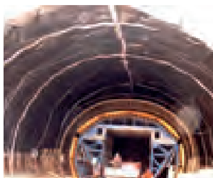
Rivestimento di una galleria con membrane prodotte da Flag a partire da PVC riciclato con il processo Vinyloop
