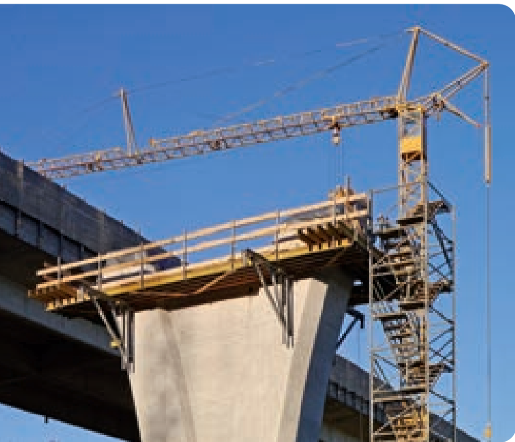
I lavori sull'Halls River Bridge
